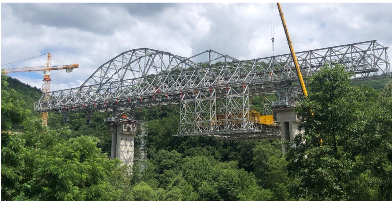
Obr. Výsuvná skruž BERD na stavbu mosta 209-02 na R2 Kriváň - Mýtňa
